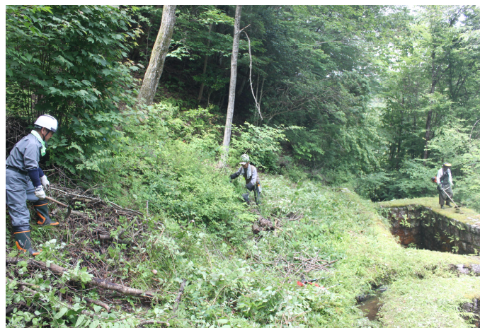
R6/6/22 原石山の中電遺構の保全作業
