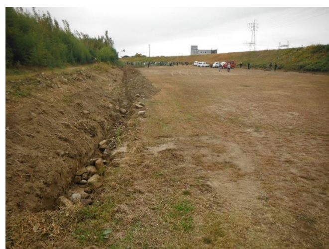
清掃後の状況
