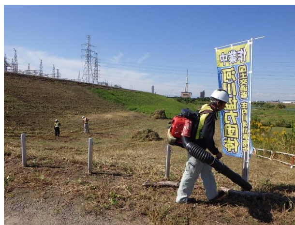
河川協力団体の旗を設置し集草作業
