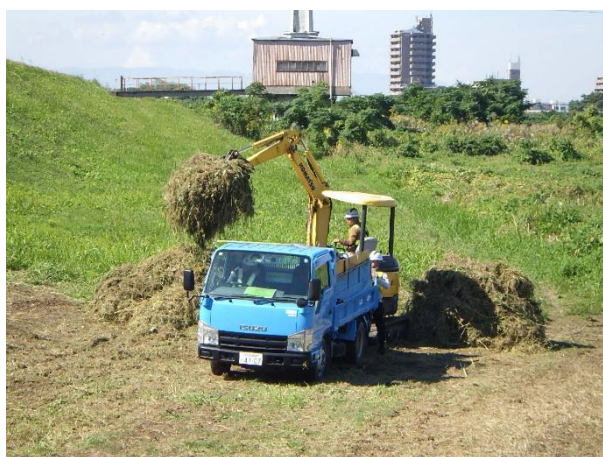
積込運搬作業
