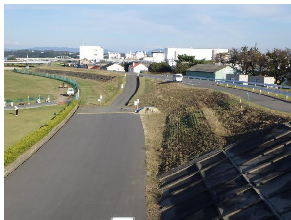
堤防除草完成写真
