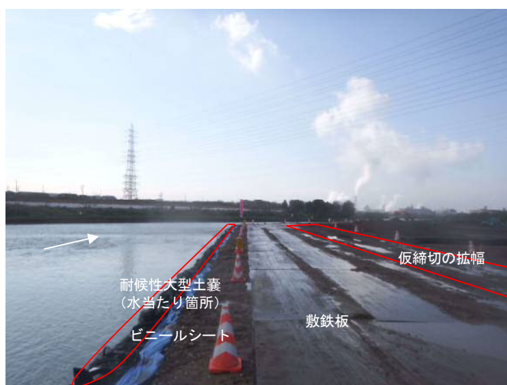
土堤締切の補強事例
