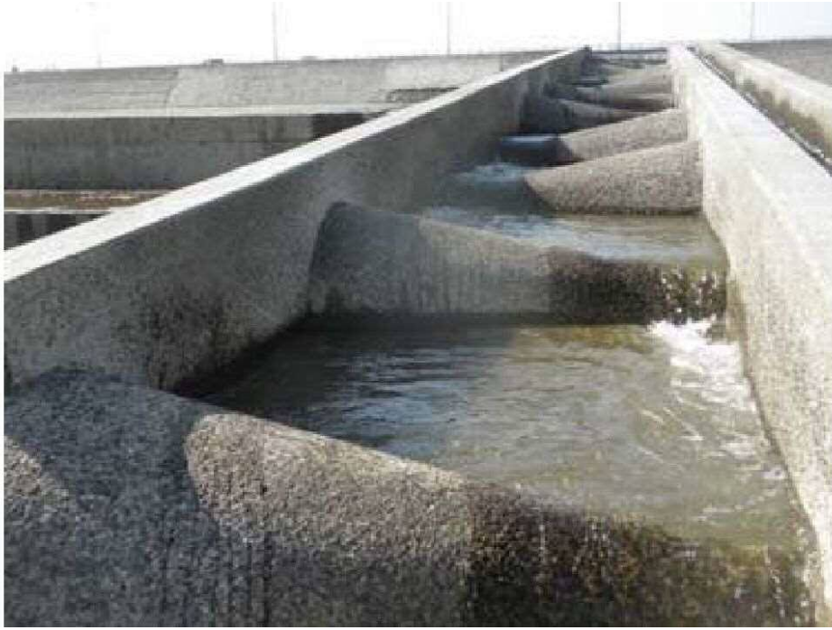
図 10-2-6 施工例写真(5) (階段式魚道)
