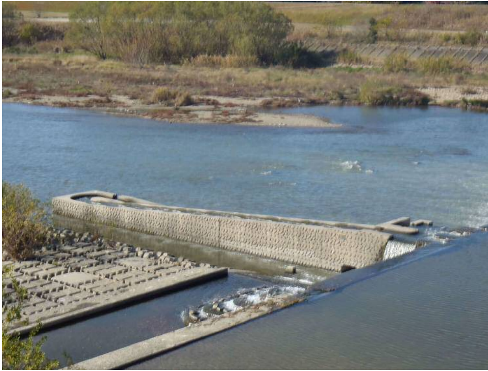
図 10-2-2 施工例写真(1) (階段式魚道)
