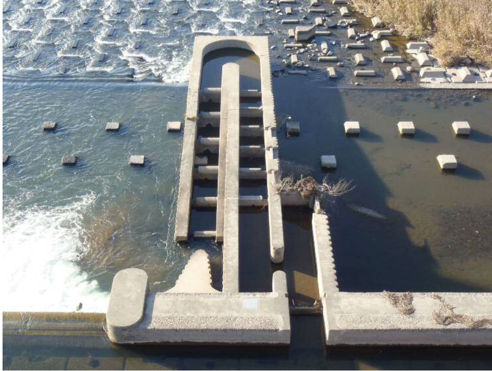
図 10-2-4 施工例写真(3) (階段式魚道)
