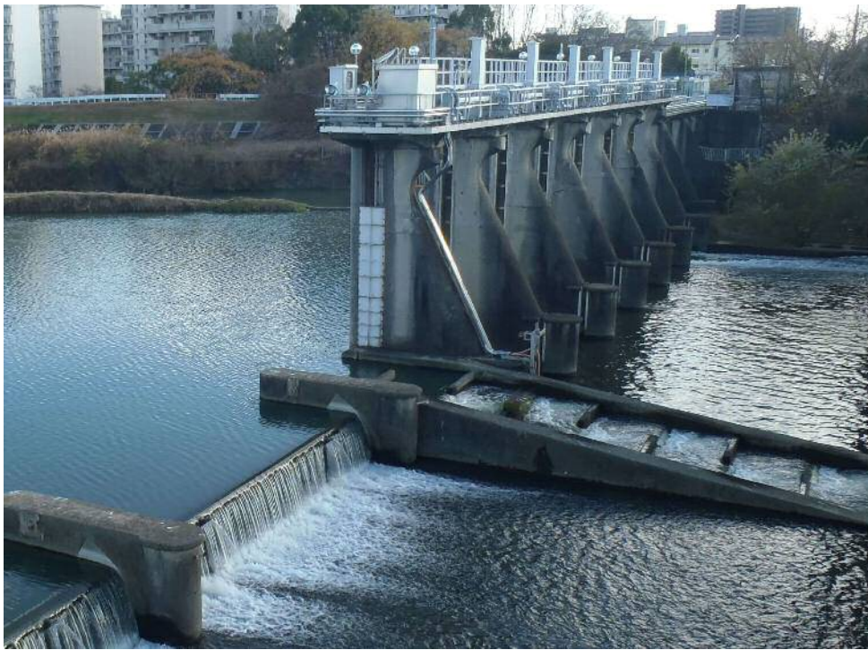
図 10-2-3 施工例写真(2) (階段式魚道)
