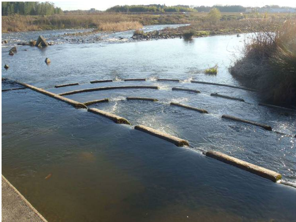
図 10-2-5 施工例写真(4) (階段式魚道)
