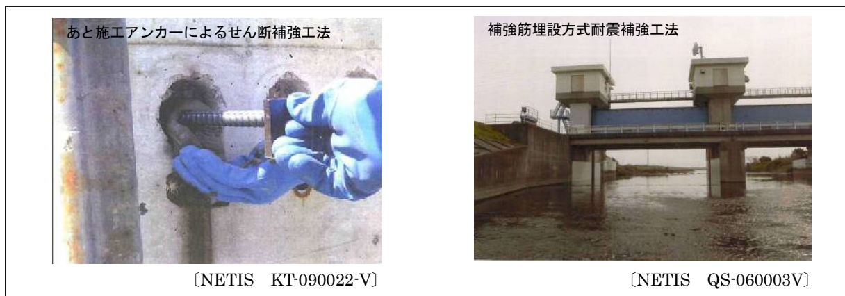
図 6-7-11 門柱補強工法の事例
