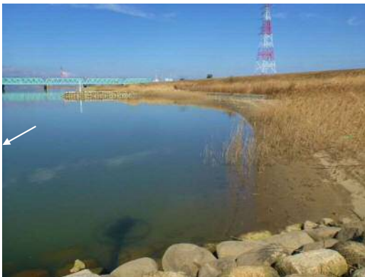
設置目的：環境水制 種類：不透過水制 材料：ブロック 向き：直角
