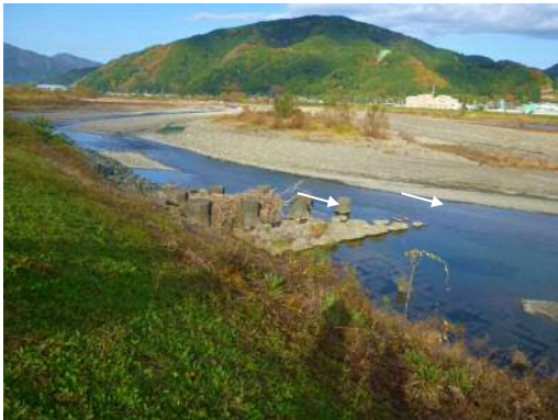
設置目的：流速減少、洗掘防止 種類：透過水制 材料：ブロック（ポスト） 向き：直角
