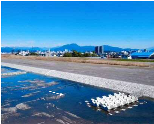
設置目的：流速減少、洗掘防止 種類：不透過水制 材料：ブロック 向き：直角
