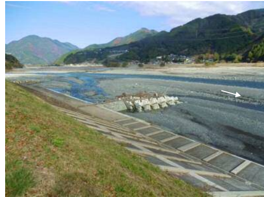
設置目的：流速減少、洗掘防止 種類：不透過水制 材料：ブロック 向き：直角
