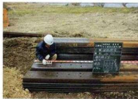
※ [多自然川づくり 施工と現場の工夫]
