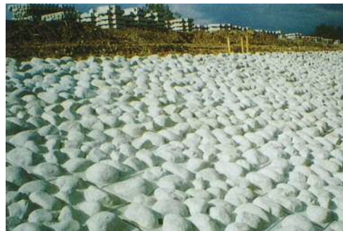
大型連節ブロックの施工事例
