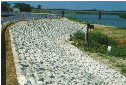
大型連節ブロックの施工事例
