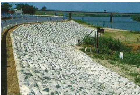
大型連節ブロックの施工事例
