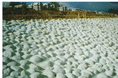
大型連節ブロックの施工事例
