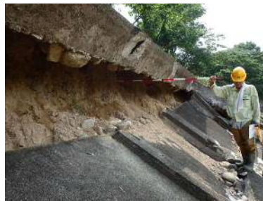
洗掘、吸い出しによる護岸の被災事例
