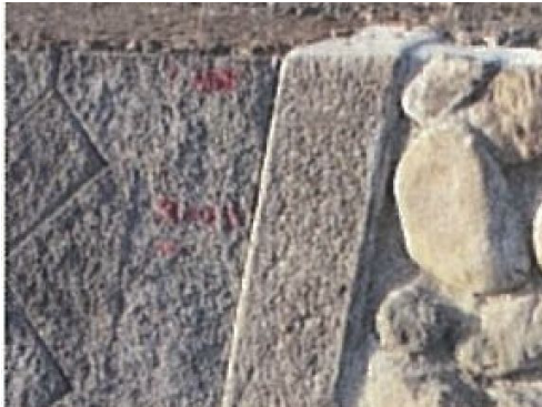
はつりによる表面処理の例
