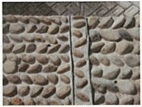
植石工による表面処理の例
