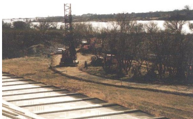
樹林を避けて工事用道路を配置した例※
