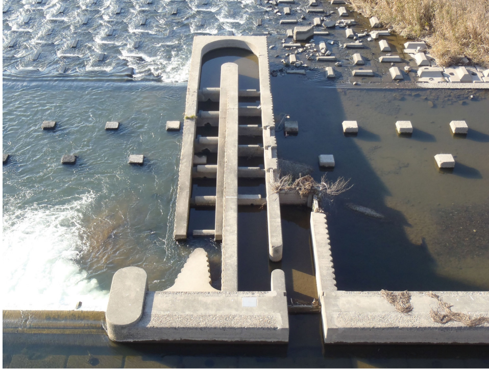
図 10-2-4 施工例写真(3) (階段式魚道)
