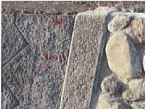
はつりによる表面処理の例
