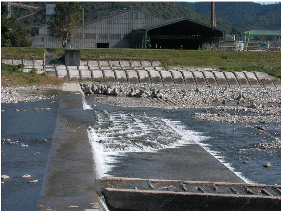
図 10-2-7 施工例写真(6) (棚田式魚道) [特許第 3448659 号] ※ ※棚田式魚道は中部地方整備局と開発者が協同で特許を取得している。
