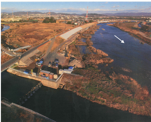
設置目的：流速減少、洗掘防止 種類：不透過水制 材料：袋状金網・石 向き：上向き
