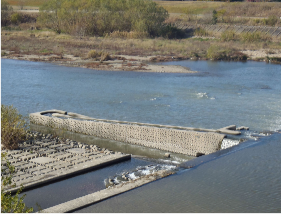
図 10-2-2 施工例写真(1) (階段式魚道)
