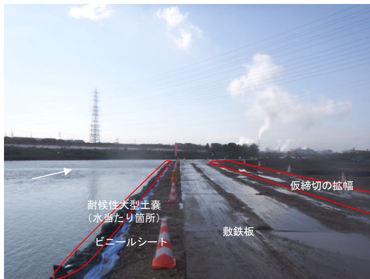
土堤締切の補強事例
