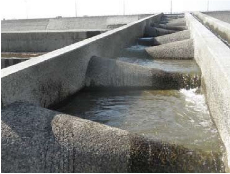
図 10-2-6 施工例写真(5) (階段式魚道)
