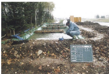
仮設のろ過施設を設けて濁水の流出を防止した例※
