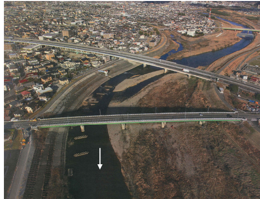
設置目的：流速減少、洗掘防止 種類：不透過水制 材料：ブロック 向き：上向き
