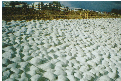
大型連節ブロックの施工事例
