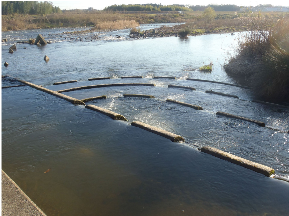
図 10-2-5 施工例写真(4) (階段式魚道)
