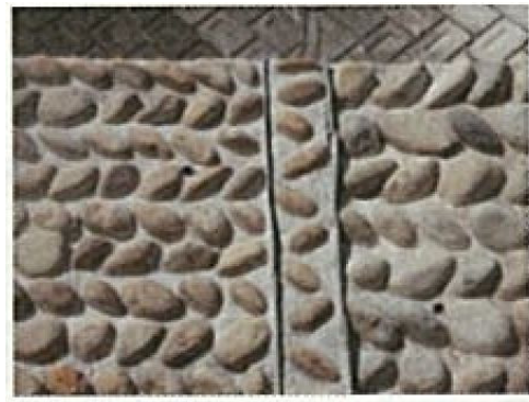
植石工による表面処理の例
