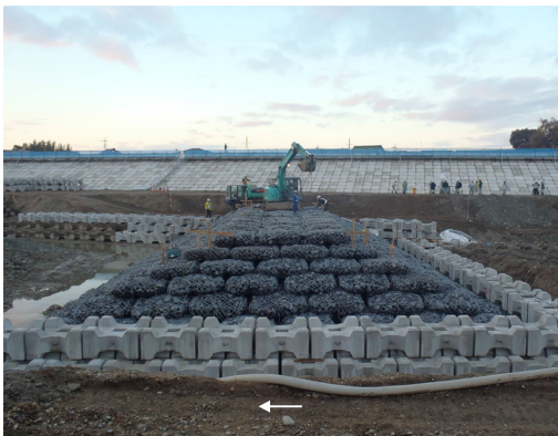
設置目的：流速減少、洗掘防止 種類：不透過水制 材料：根固マット・ブロック 向き：上向き
