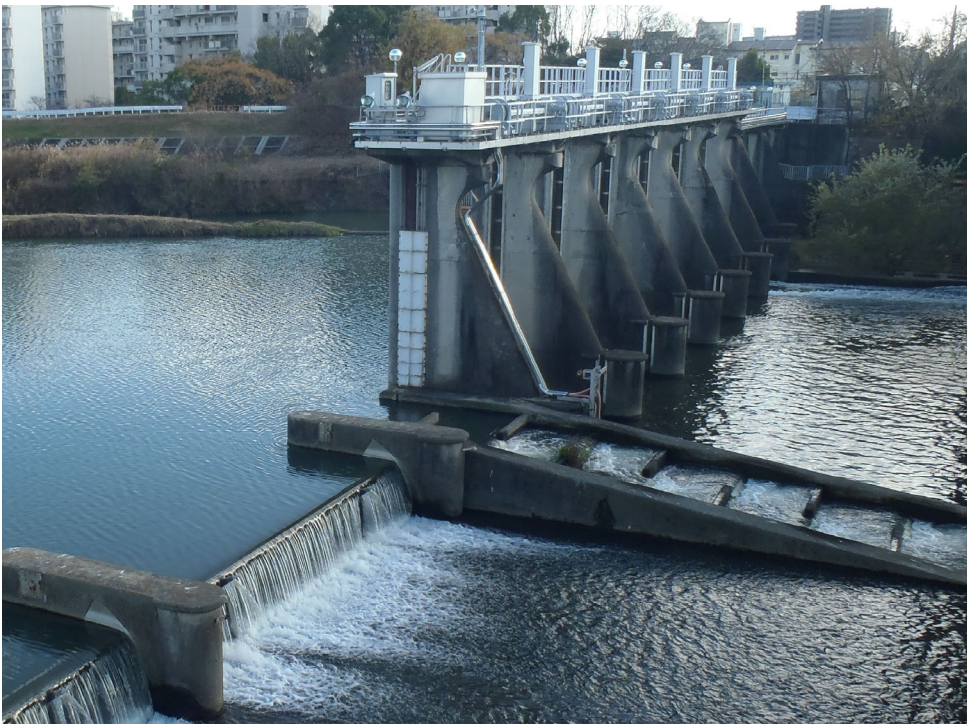
図 10-2-3 施工例写真(2) (階段式魚道)
