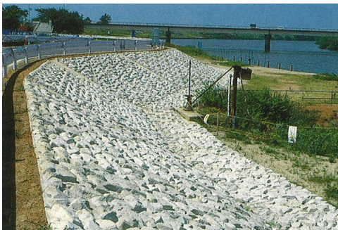
大型連節ブロックの施工事例
