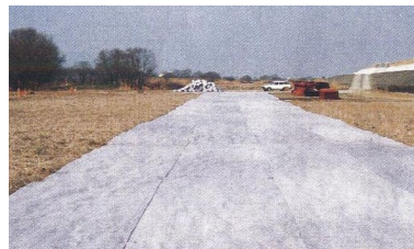
搬入土を用いる際にシートを敷いて土が混ざらないように配慮した例※
