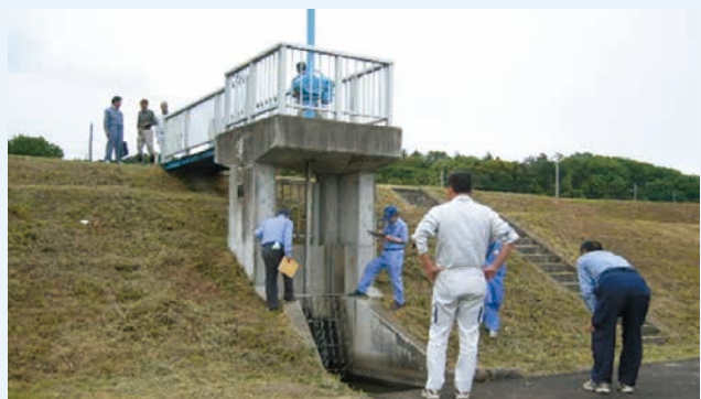
河川管理施設（樋管）の点検状況。洪水から地域が守られるよう定期的な点検によって、河川管理施設の状況を確認。
