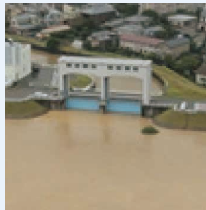
洪水時の水門。本川の水位が高くなった際に、水門を閉鎖することで、本川の洪水を支流に逆流させないようにしています。
