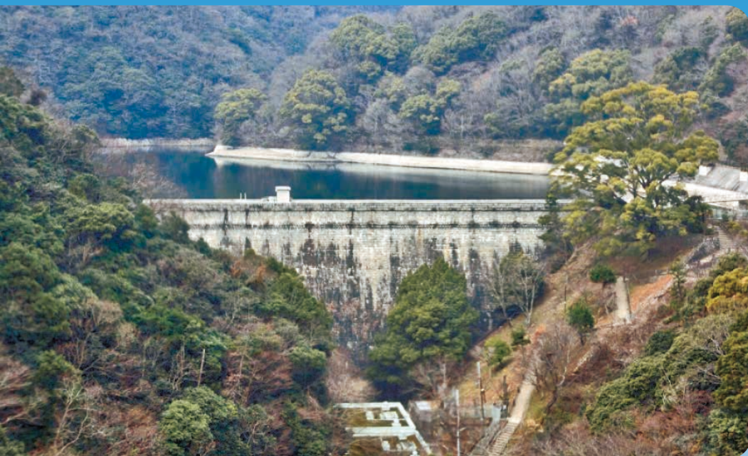
布引五本松ダム（我が国最初（1900年竣工）の重力式コンクリートダム。現在も神戸市の水源として使用されている）
