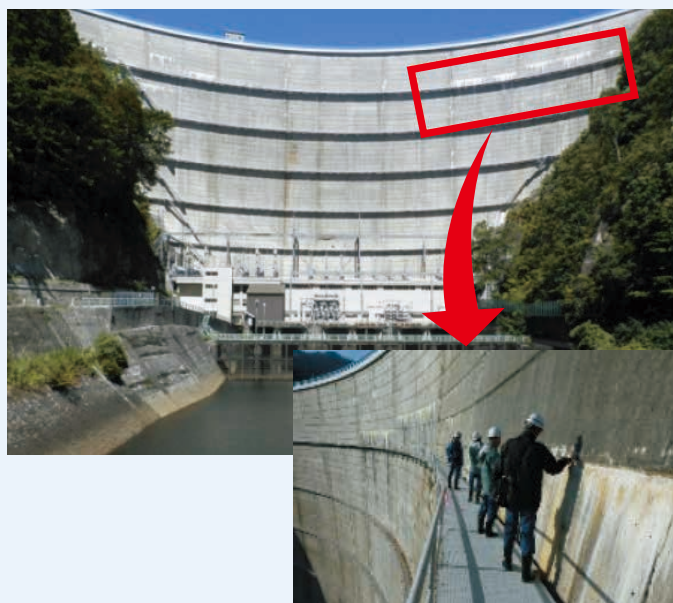
3年に1回実施する定期検査にて、キャットウォーク（管理用通路）を使用したダム堤体の検査の様子です。ダム堤体コンクリートは、健全性が保たれています。
