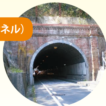
小坪隧道・名越隧道
