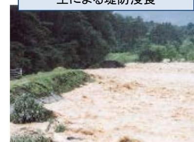
✓ 河道の変化(樹林化)によって、偏流の発生による堤防の浸食、流下能力の低下が生じる。→ 樹木管理が最重要
