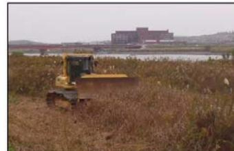
写真) ブルドーザー踏み倒し状況
