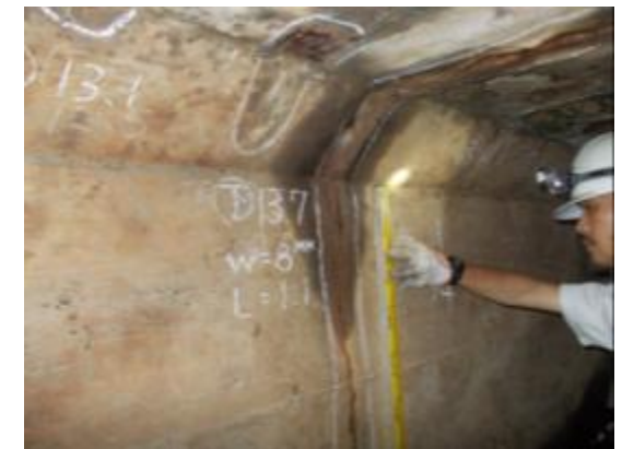
函体鉄筋の露出と腐食
