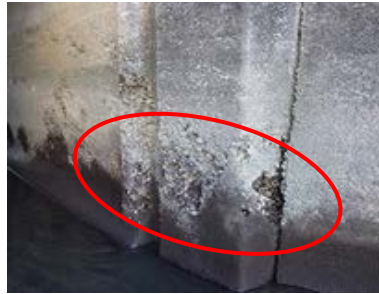
函渠(函体) のジャンカ
