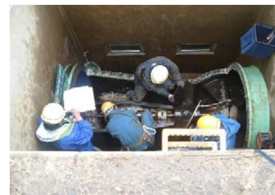
(ポンプ設備の点検・整備)
