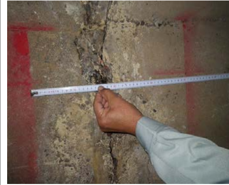
函渠(函体)のクラック、頂版のズレ
