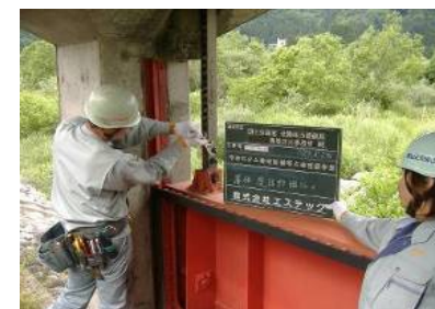
(樋門ゲートの点検)
