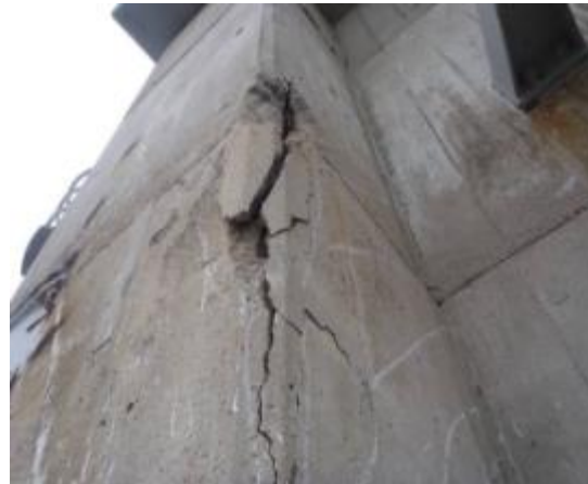
門柱部のコンクリート剥離等劣化状況 管理橋床板部のコンクリート劣化状況
