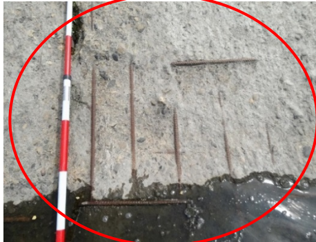
床版・水叩き部の摩耗による鉄筋露出
