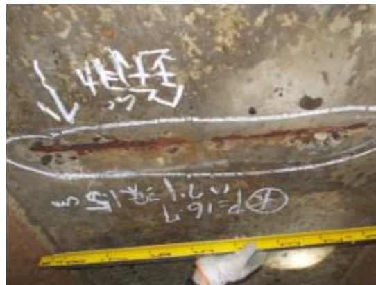
函体鉄筋の露出と腐食
