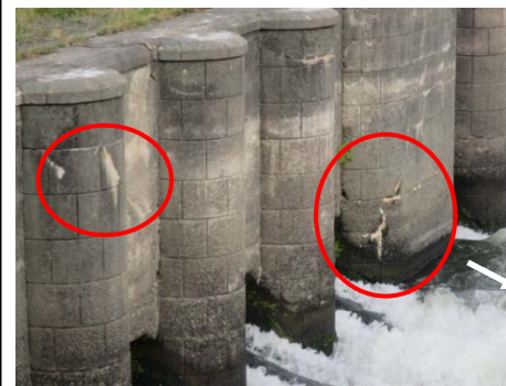
堰柱の破損・損傷
