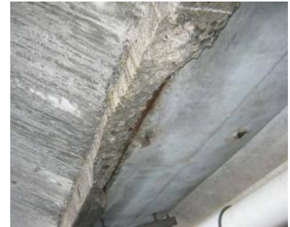
門柱部のコンクリート剥離等劣化状況 管理橋床板部のコンクリート劣化状況
