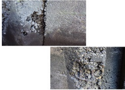
函渠(函体) のジャンカ
