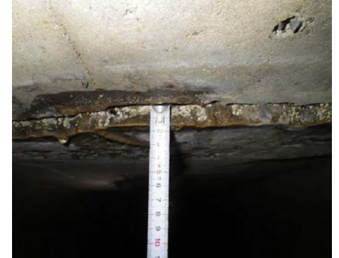
函渠(函体)のクラック、頂版のズレ
