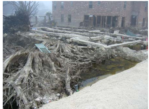
堤防付近は依然として被災時のまま。
