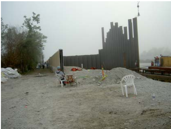
堤防の暫定改修工事中。
