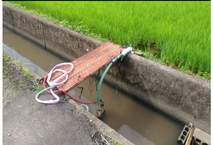
農家の対応状況(ほ場へのポンプによる汲み上げ)(H29.6.28)
