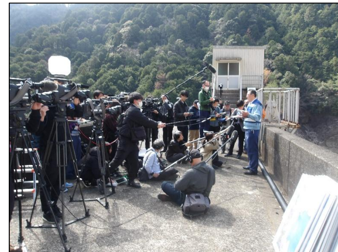
宇連ダム緊急取水現地説明会 令和8年3月17日
