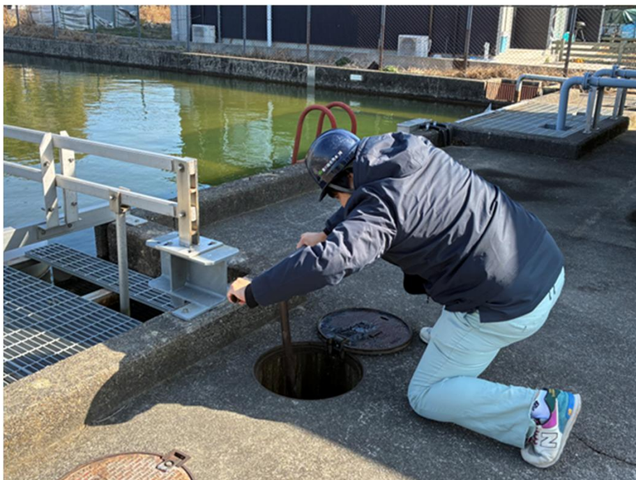
少量配水に対応したバルブの きめ細やかな開閉操作
