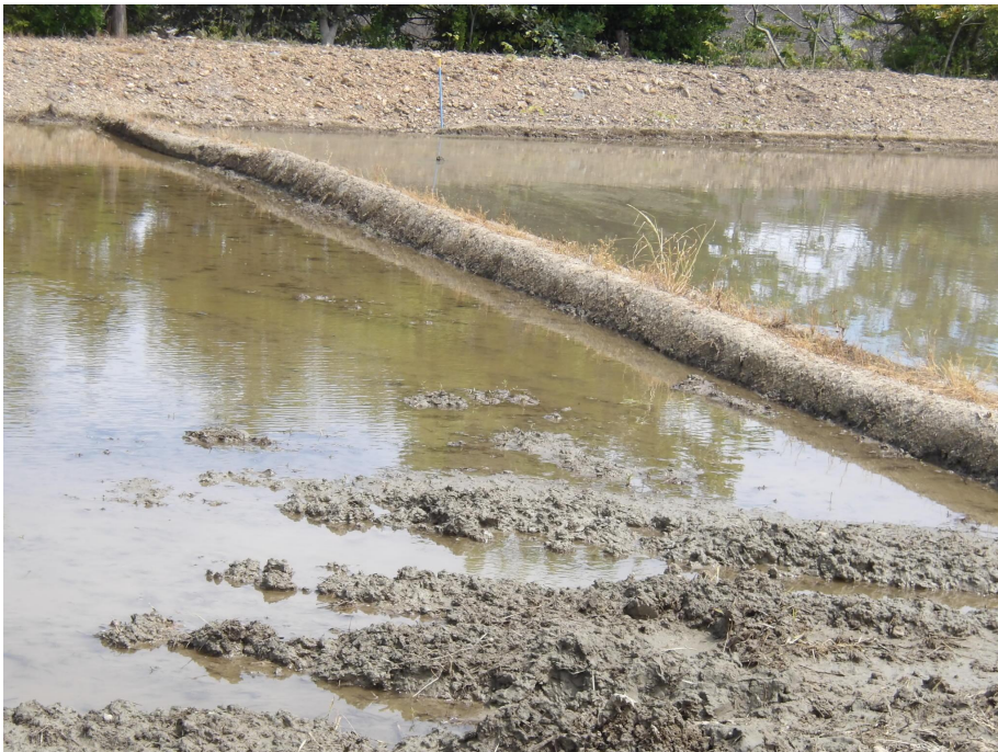
畦塗による水田からの漏水防止
