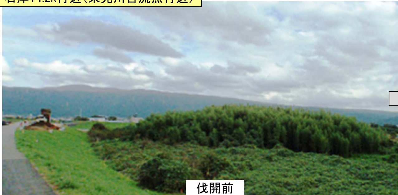
右岸14.2k付近(来光川合流点付近)
