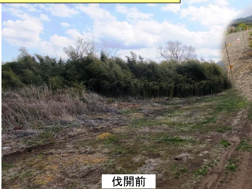
左岸11.4k付近(新城橋下流)
