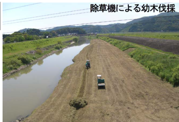
幼木除草による対策事例 (四国：四万十川水系中筋川)
