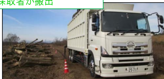
伐開した樹木(幹)を現場内集積し 公募した採取者が搬出
