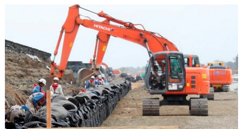
海岸堤防応急復旧
