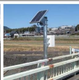
簡易型河川監視カメラ
