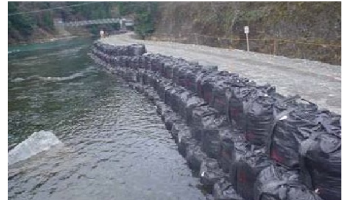
大型土のう工法施工事例
