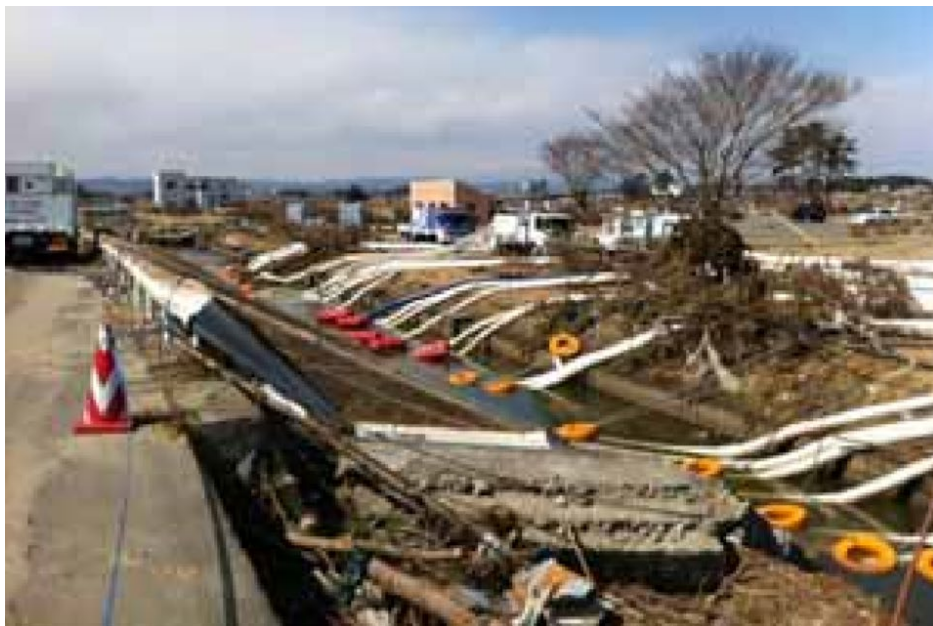
図 6-11 排水ポンプ車の釜場例
