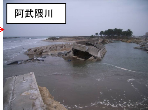
河川堤防と海岸堤防が接する隅角部
