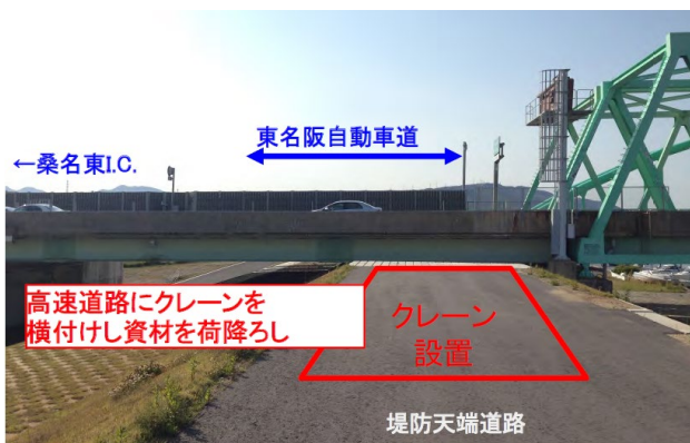
東名阪自動車と揖斐川堤防道路の立体交差点部 (揖斐川右岸8.0k付近)
