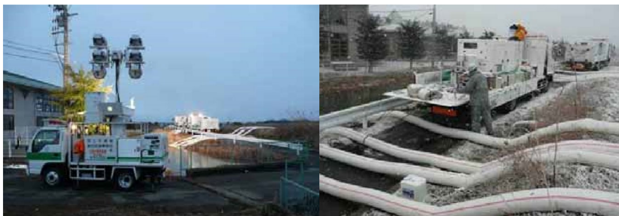
図 6-12 排水作業の様子（東日本大震災時）
