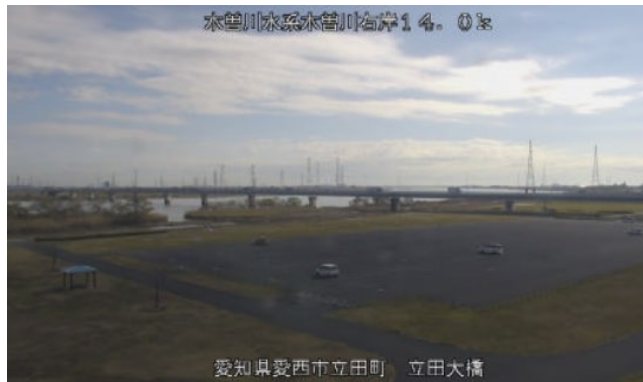
図 7-6 CCTVカメラ映像
