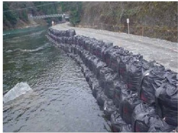
図 4-5 大型土のう工法による施工事例
