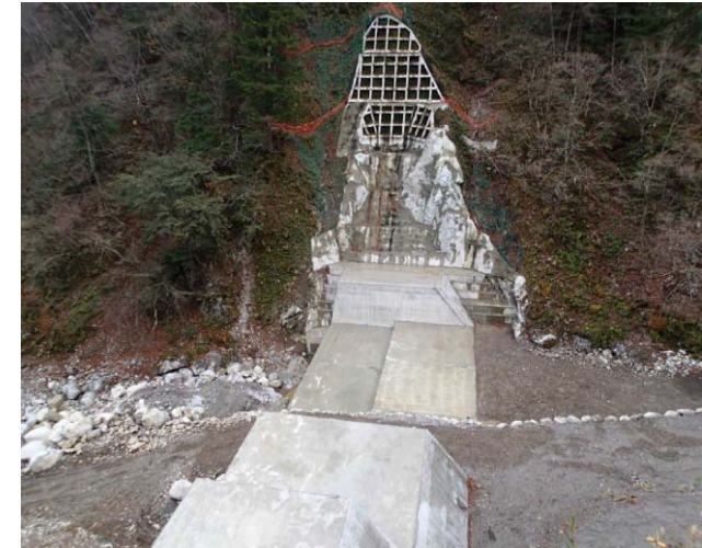
主堰堤右岸の様子(H27.3末時点)
