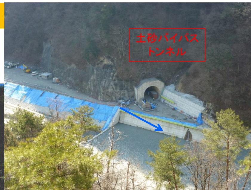
吐口周辺（平成28年2月撮影）
