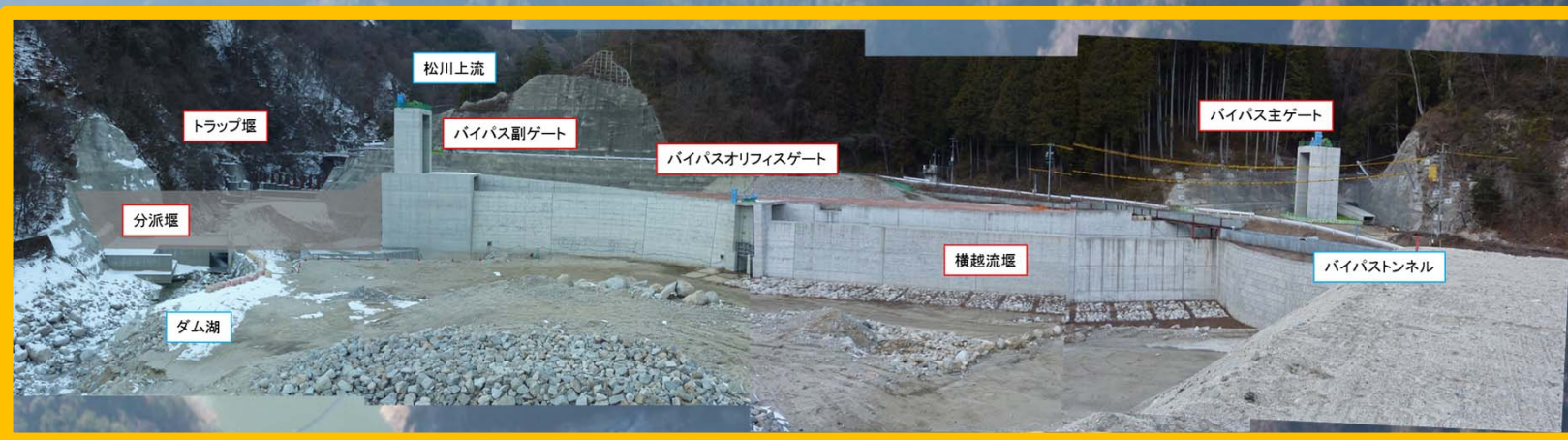
バイパス施設(呑口側)全景状況
