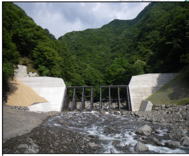
梶谷第4砂防堰堤【飯田市南信濃】（平成22年3月完成）
