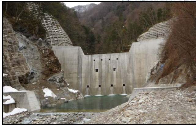
中田切第4砂防堰堤【駒ヶ根市】（平成23年3月完成）
