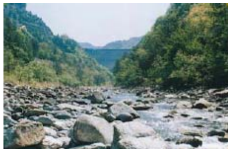
下流河道の様子
