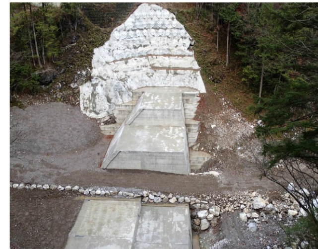
主堰堤左岸の様子(H27.3末時点)
