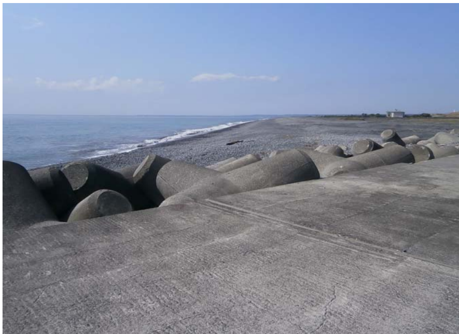
工事施工前 平成28年4月
