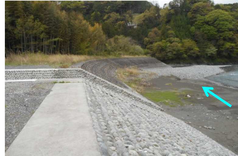
川根本町青部地先の堤防・護岸整備状況
