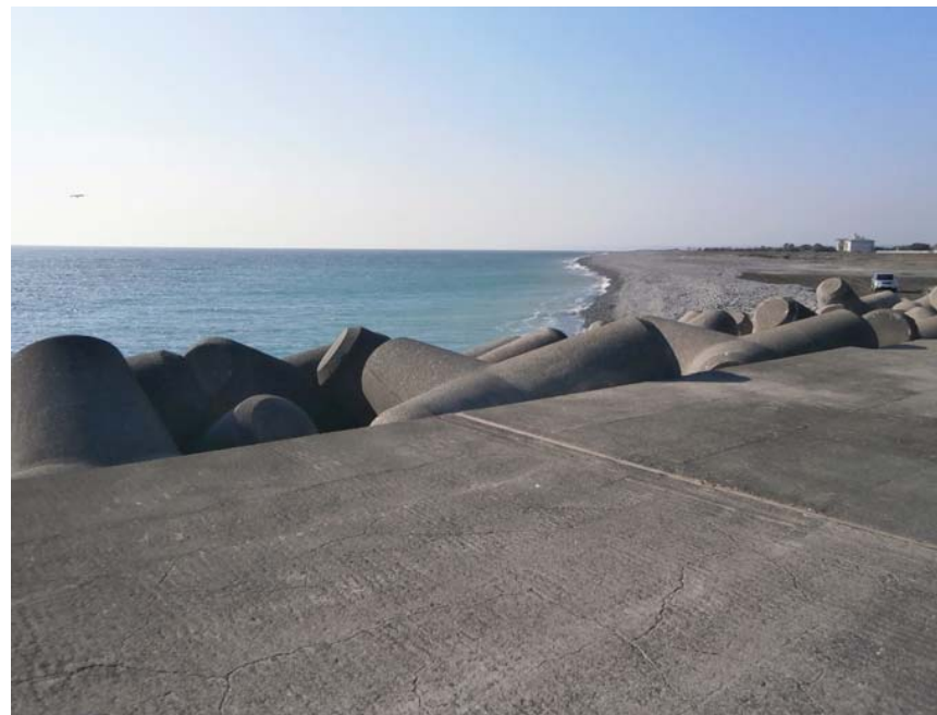
工事施工後 平成29年1月
