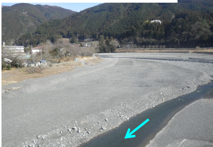
H25河床掘削完了区間の状況(川根本町千頭)
