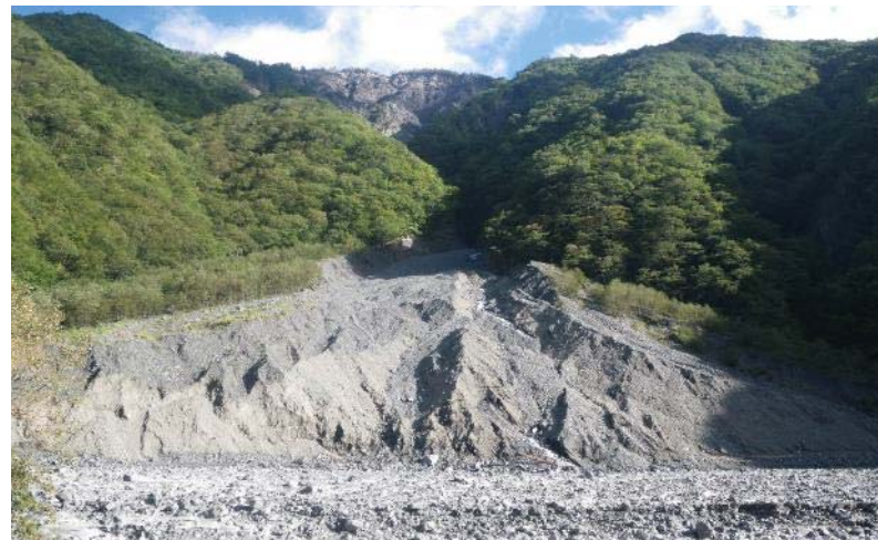
【赤崩からの土砂の流入状況】
