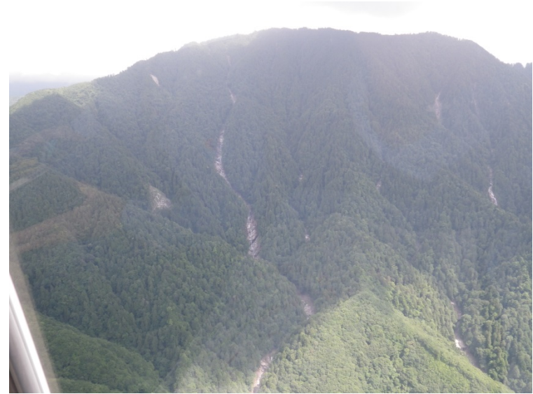
梨子沢上流の崩壊地
