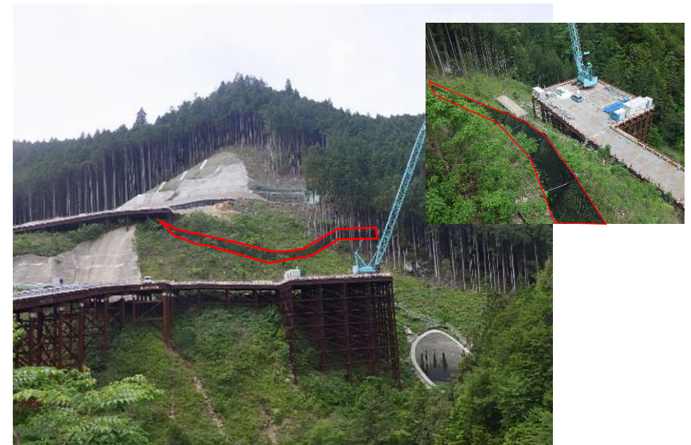
落石防護柵を施工
