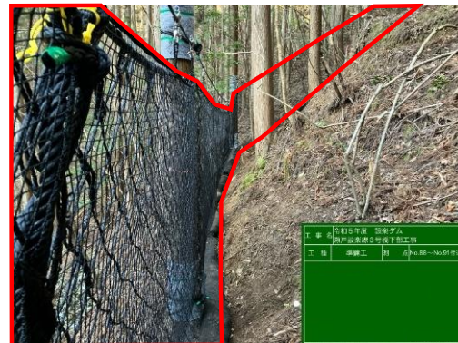
落石防護柵を施工
