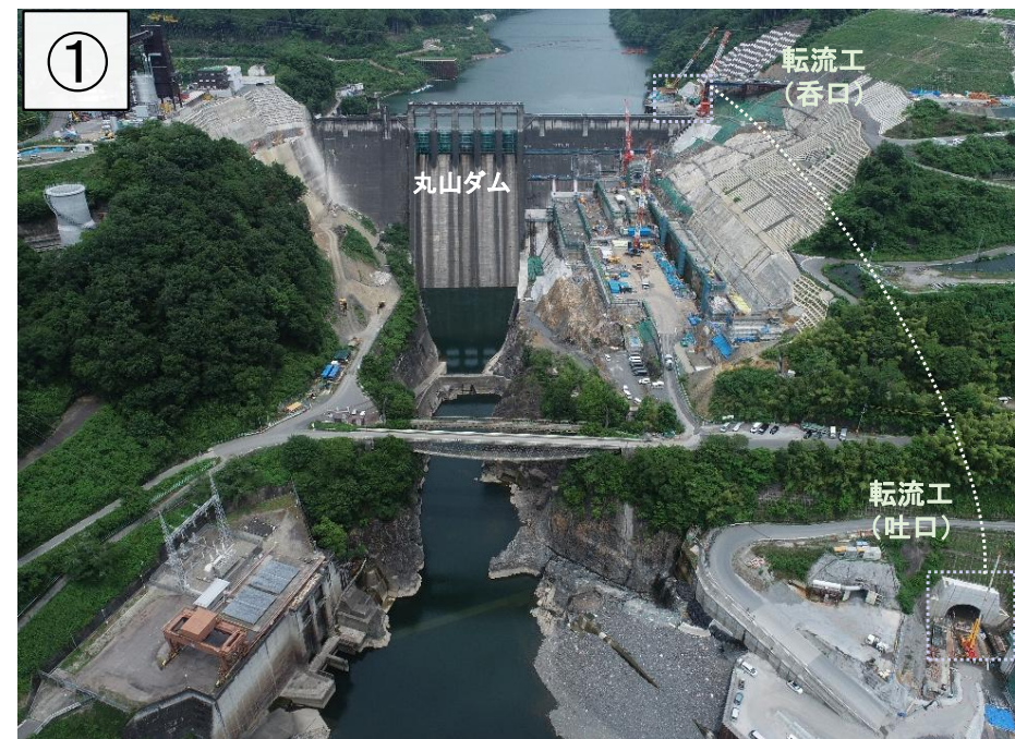
堤体 (下流より上流を望む)
