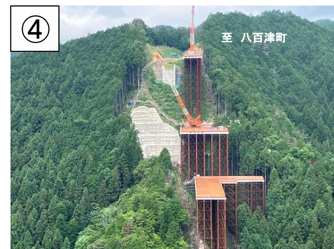
国道418号7号橋(仮称)八百津町潮見側
