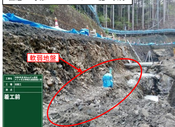
国道418号線 ルートパイル工施工状況
