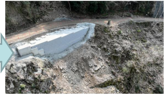
工事用道路工事（拡幅）
