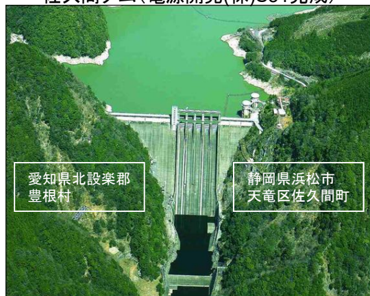
佐久間ダム(電源開発(株)S31完成)
