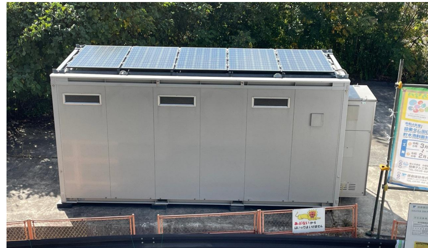
③太陽光発電を備えた仮設ソーラーハウス
