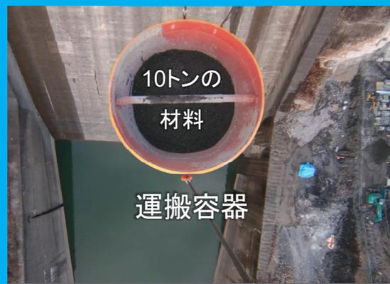
カメラで運搬容器下の障害物を検出し事故防止
