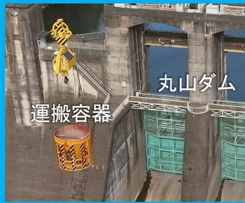
運搬容器の揺れ動きをセンサーで感知・制御
