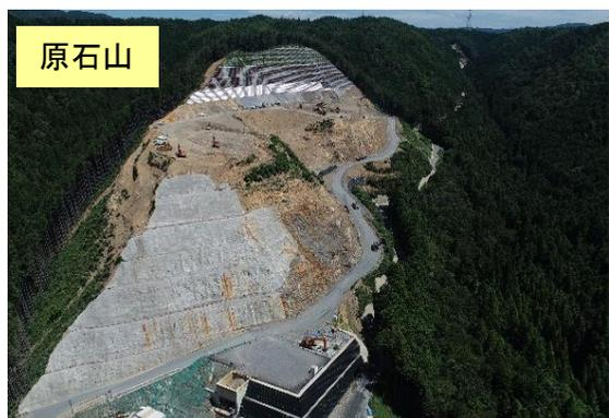
施工内容：原石山の表土掘削、原石採取
