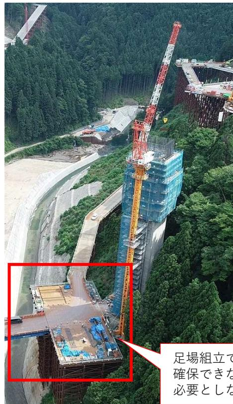
足場組立てのための十分な施工ヤードが確保できないため、ヤードでの組立てを必要としない「自動昇降式足場」を採用
