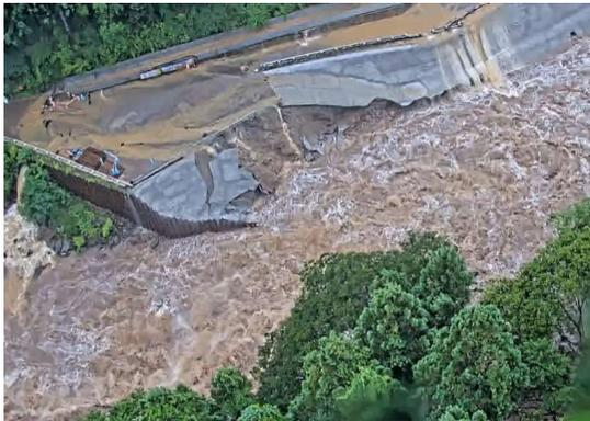
出水時(法面の崩壊)(令和5年6月2日)
