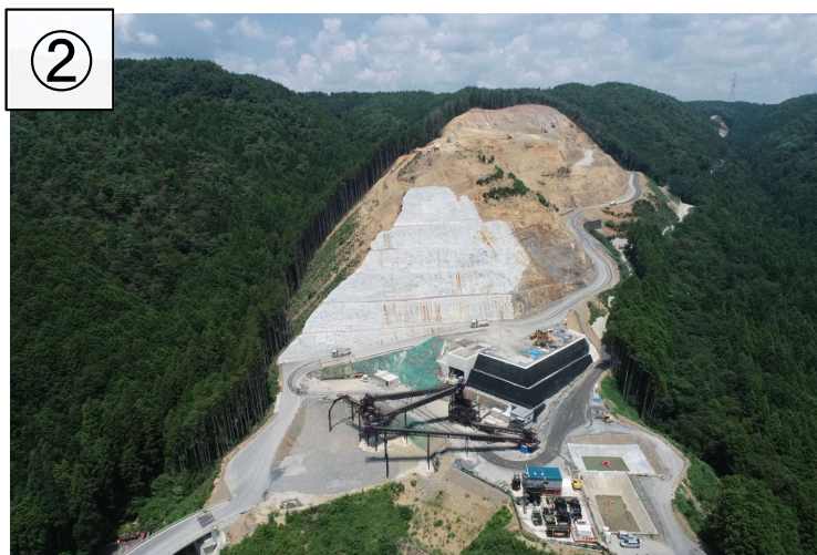
原石山 全景 令和6年8月撮影
