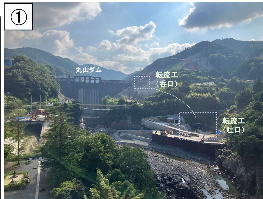
堤体 (下流より上流を望む)
