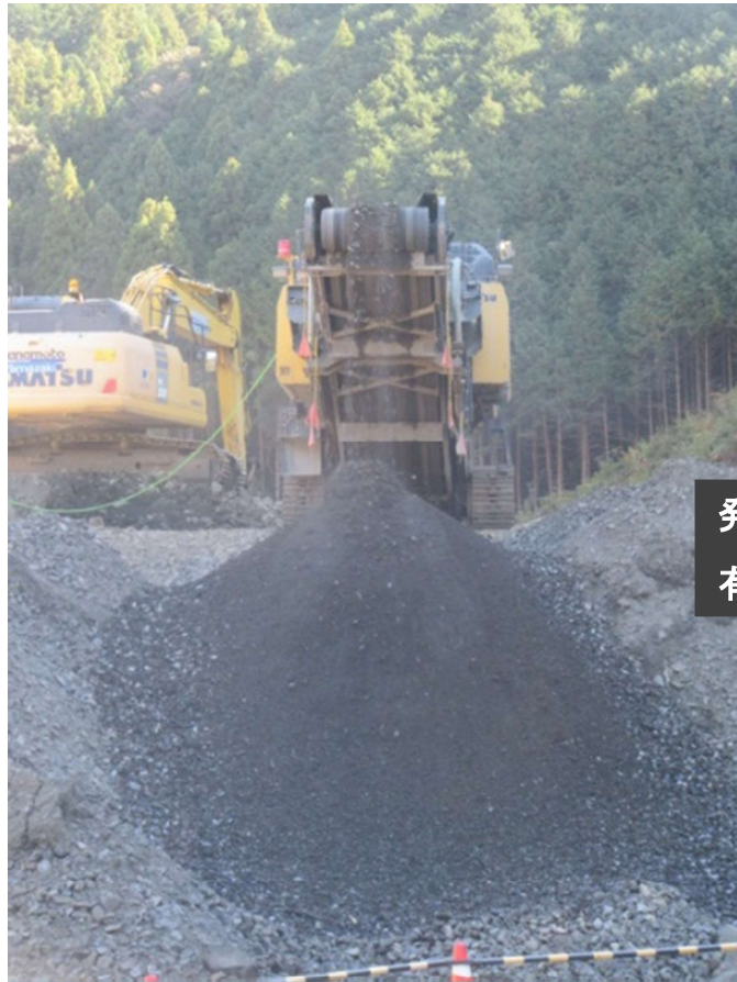
ダム本体掘削の発生土(岩石)の破碎状況
