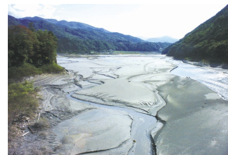
美和ダムの堆砂状況(平成11年撮影)
