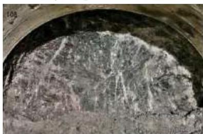
砂質片麻岩主体の掘削面
