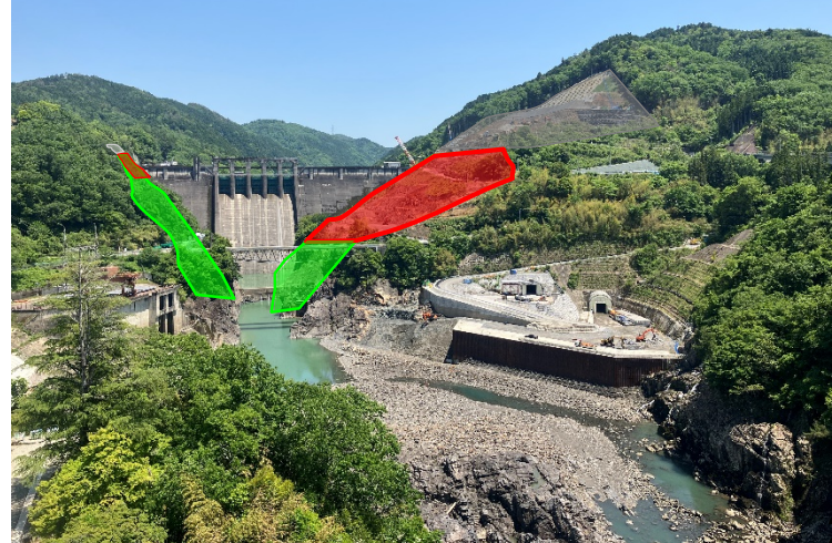
上空写真(掘削範囲)
