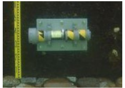
濁度計設置の様子
