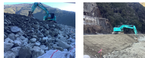
巨石積施工写真
