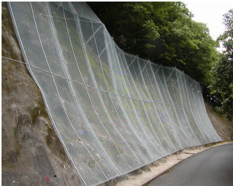
ポケット式落石防護網+予防工
