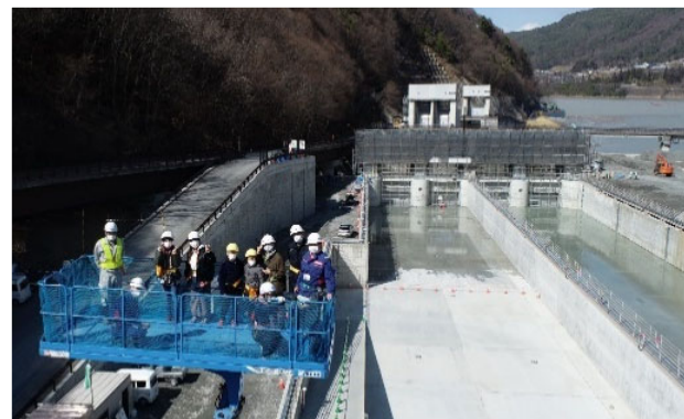
高所作業車から施設全体を見学
