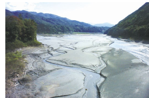
美和ダムの堆砂状況(平成11年撮影)
