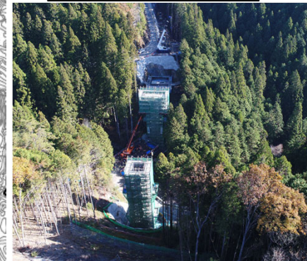
8号橋(仮称)下部工事
