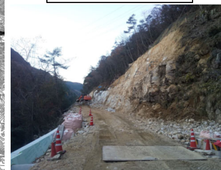
大西瑞浪線 拡幅工事
