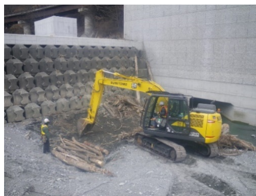
流木撤去作業状況
