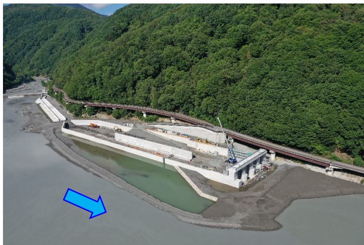
ストックヤード施工状況
