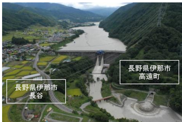
下流より美和ダムを望む(美和ダムS34完成)
