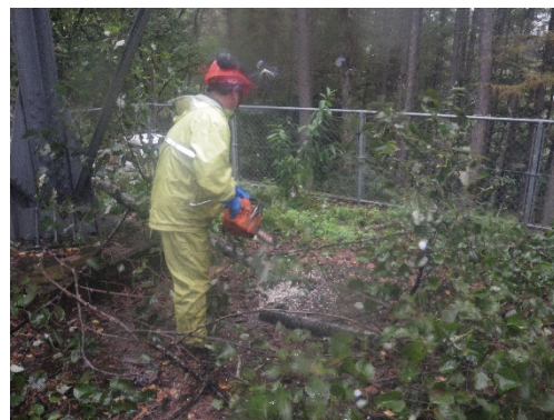
倒木撤去作業状況
