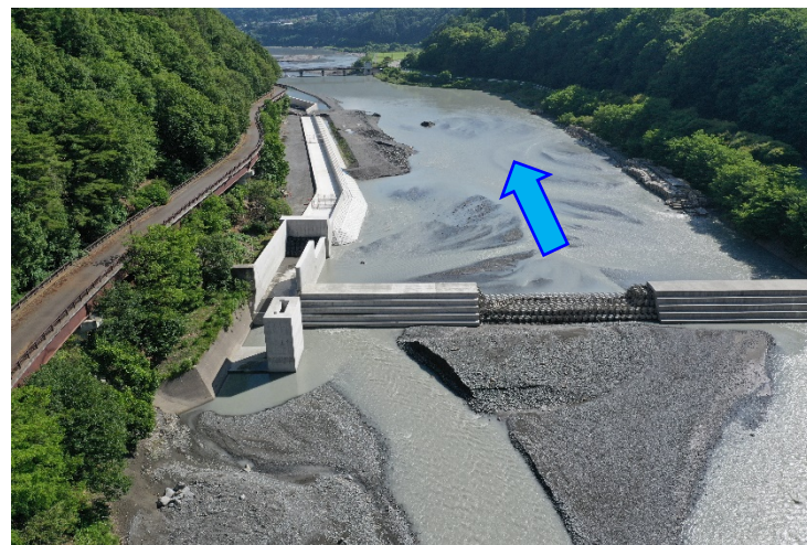
導水路施工状況
