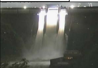
美和ダム放流状況 (10月12日22:19)
