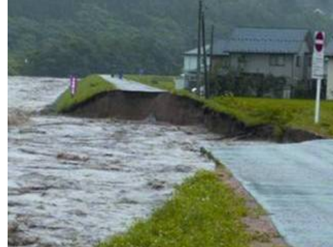
H18.7災害 堤防決壊(箕輪町松島地区)
