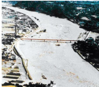
S58.9災害 飯田市松尾地区
