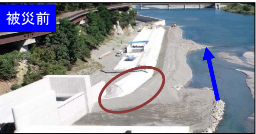
導水路護岸の被災
