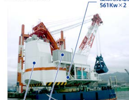
浚渫船 旋回台
