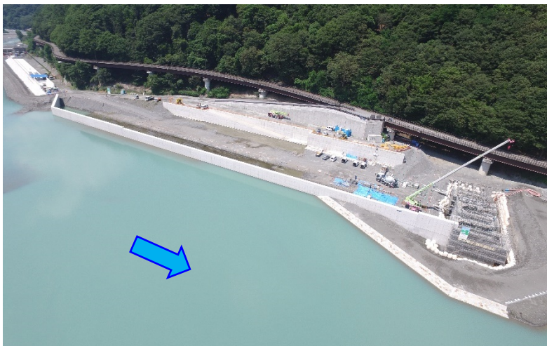
ストックヤード施工状況
