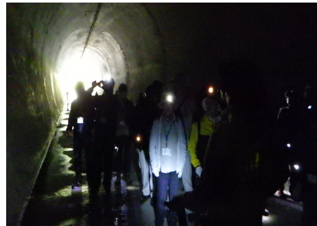
土砂バイパストンネル内部
