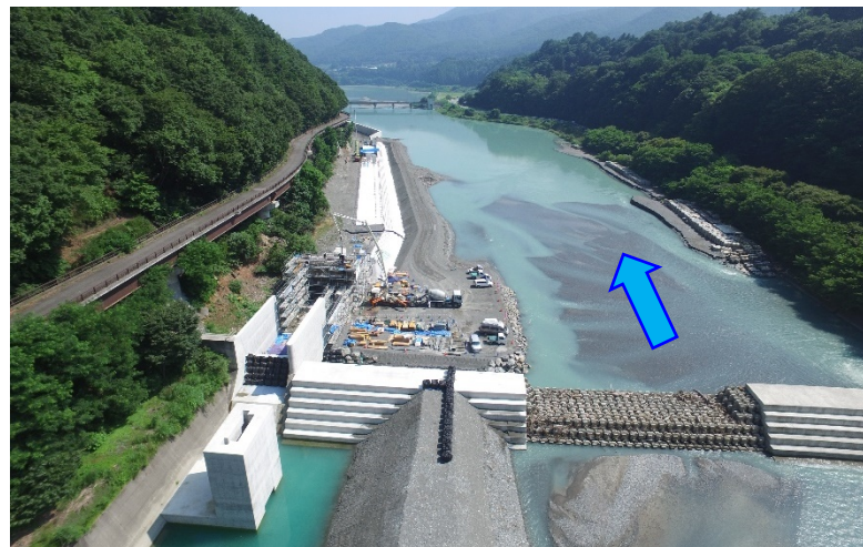
導水路施工状況
