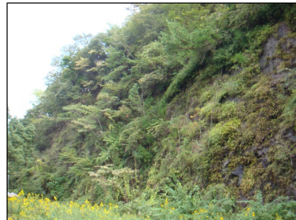
対策斜面近接
