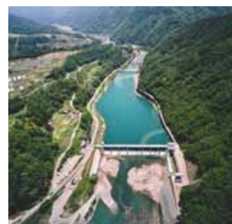
分派堰・土砂バイパストンネル
