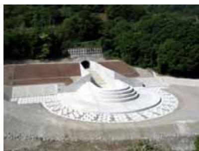
土砂バイパストンネル吐口
