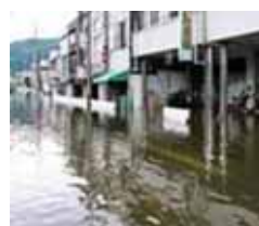
H18.7 災害 諏訪市上諏訪地区
