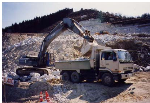
[原石の採取工事のイメージ]
