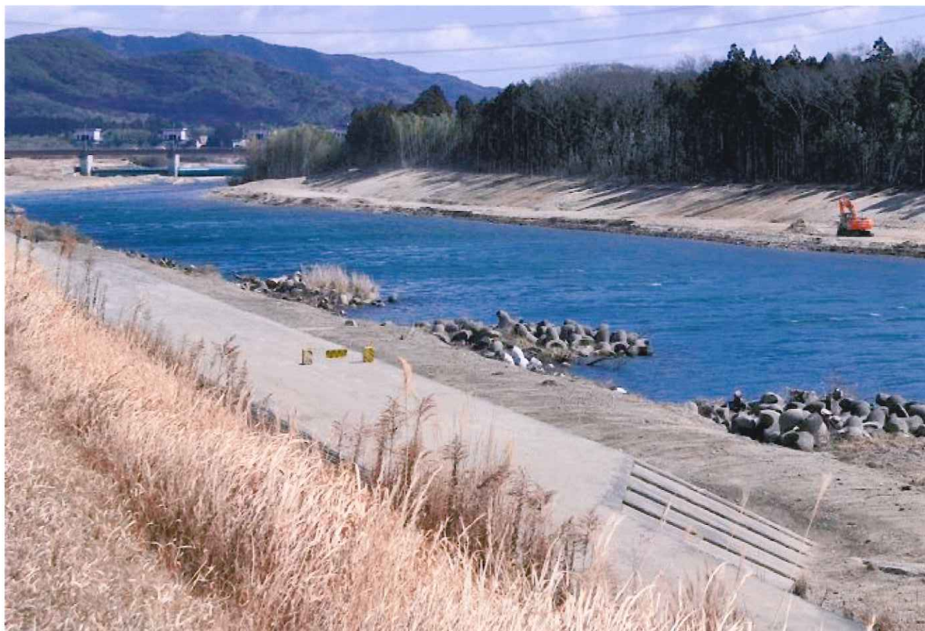
↑ 豊川の治水 新城市-桑田の低水路拡幅+樹木除去(2013. 02)、対岸の掘削部が低水路拡幅(かつて竹藪が茂っていた)部分、上流側に見えるのが牟呂松原頭首工(石田基準点は頭首工から2.0 km上流)
