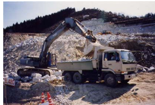
[原石の採取工事のイメージ]
