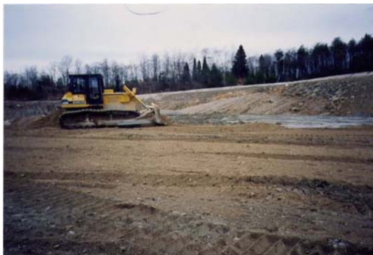
[建設発生土の処理工事のイメージ]
