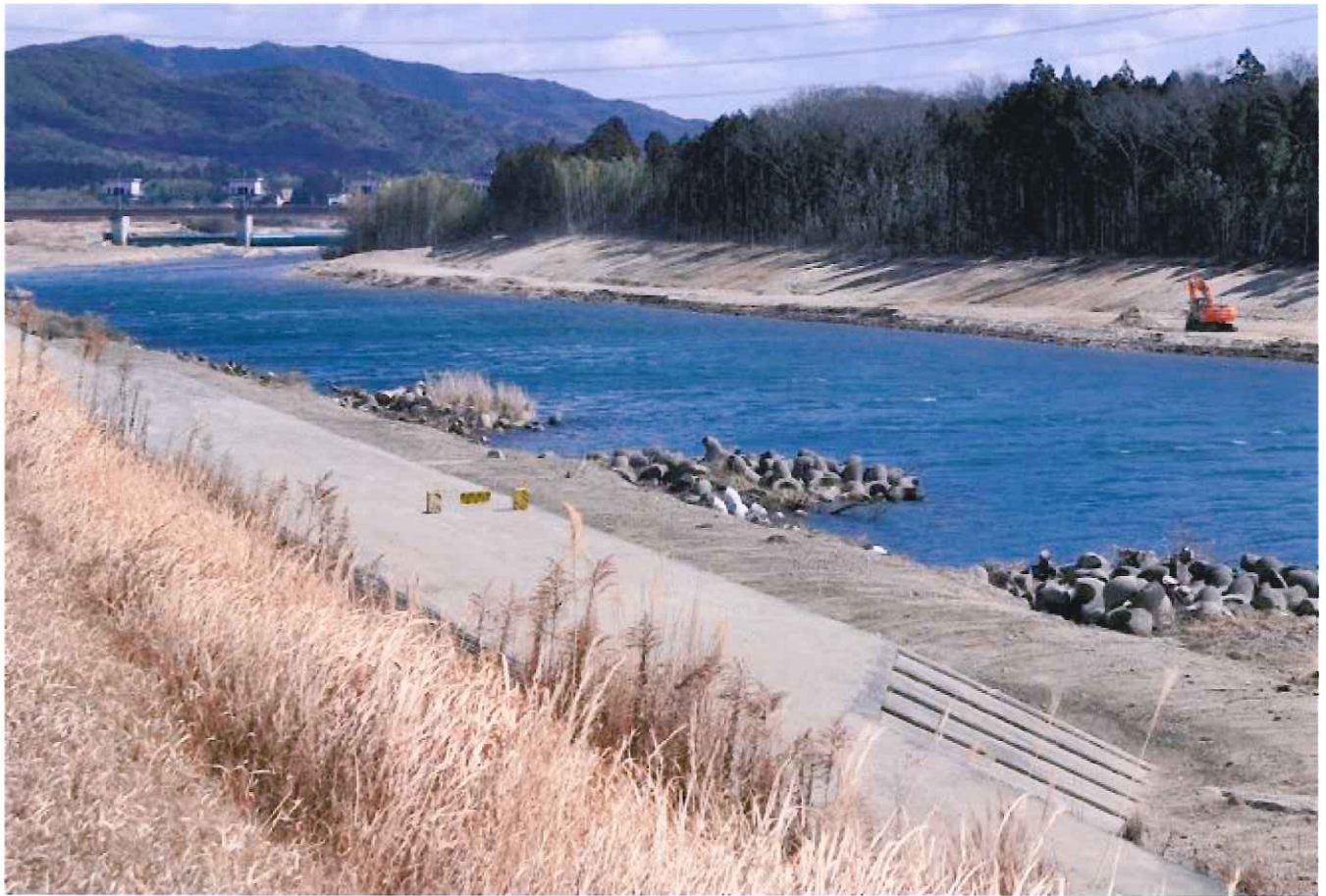
↑ 豊川の治水 新城市-桑田の低水路拡幅+樹木除去(2013. 02)、対岸の掘削部が低水路拡幅(かつて竹藪が茂っていた)部分、上流側に見えるのが牟呂松原頭首工(石田基準点は頭首工から2.0 km上流)
