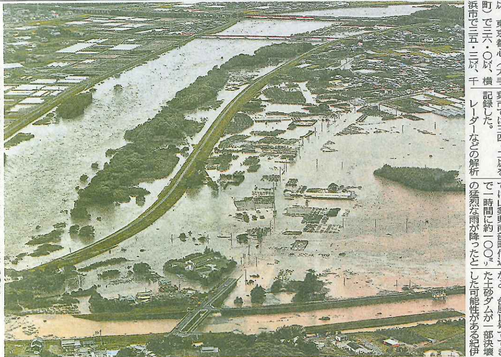
台風15号による大雨で冠水した豊橋市内。左は豊川、21日午後4時40分、愛知県豊橋市豊町で、本社へ「おひる」から(野村大輔撮影)
