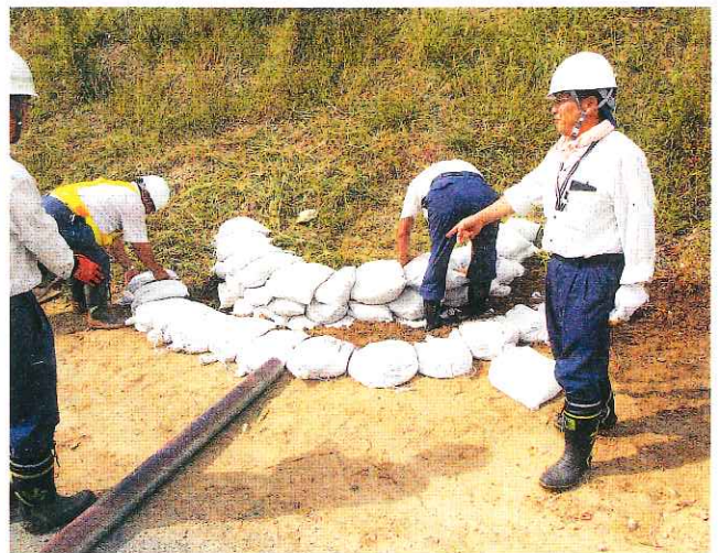
月の輪工法作業中
