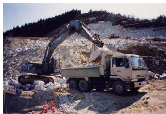
〔原石の採取工事のイメージ〕
