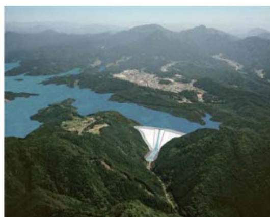
〔設楽ダム完成予想図（ダム下流から設楽町田口方向を望む）〕 <貯水池の水位はサーチャージ水位（標高444.0m）>
